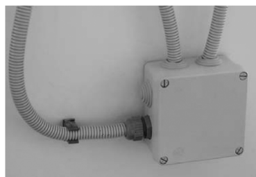
Рис. 17.118. Кабельный ввод ( а ); соединение пластмассовой гофрированной трубы с коробкой через кабельный ввод ( б ); гофрированная труба оконцованная кабельным вводом ( в ); уплотнение труб через ниппель (вверху коробки) и кабельный ввод (слева) — ( г )
